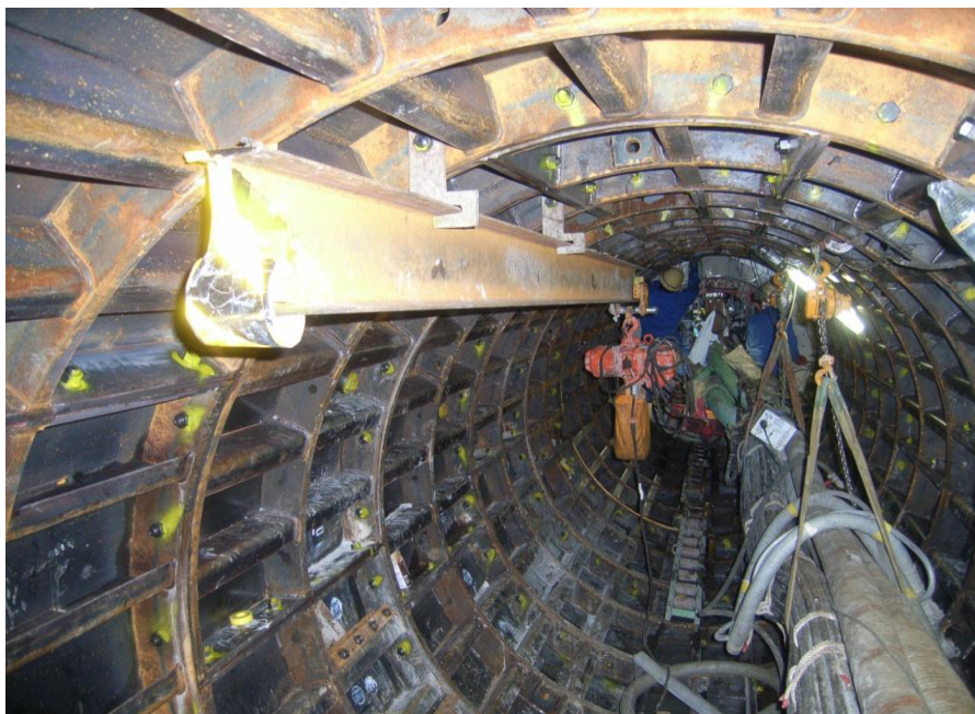
ガスパイプライン敷設用シールドトンネル掘進状況 (提供：東邦ガス)
