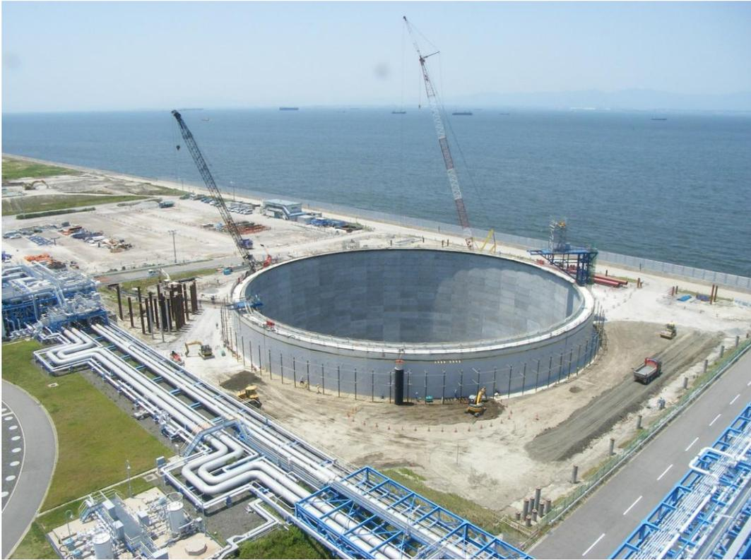
20万k1地下式LNGタンク建設状況（提供：東邦ガス）
