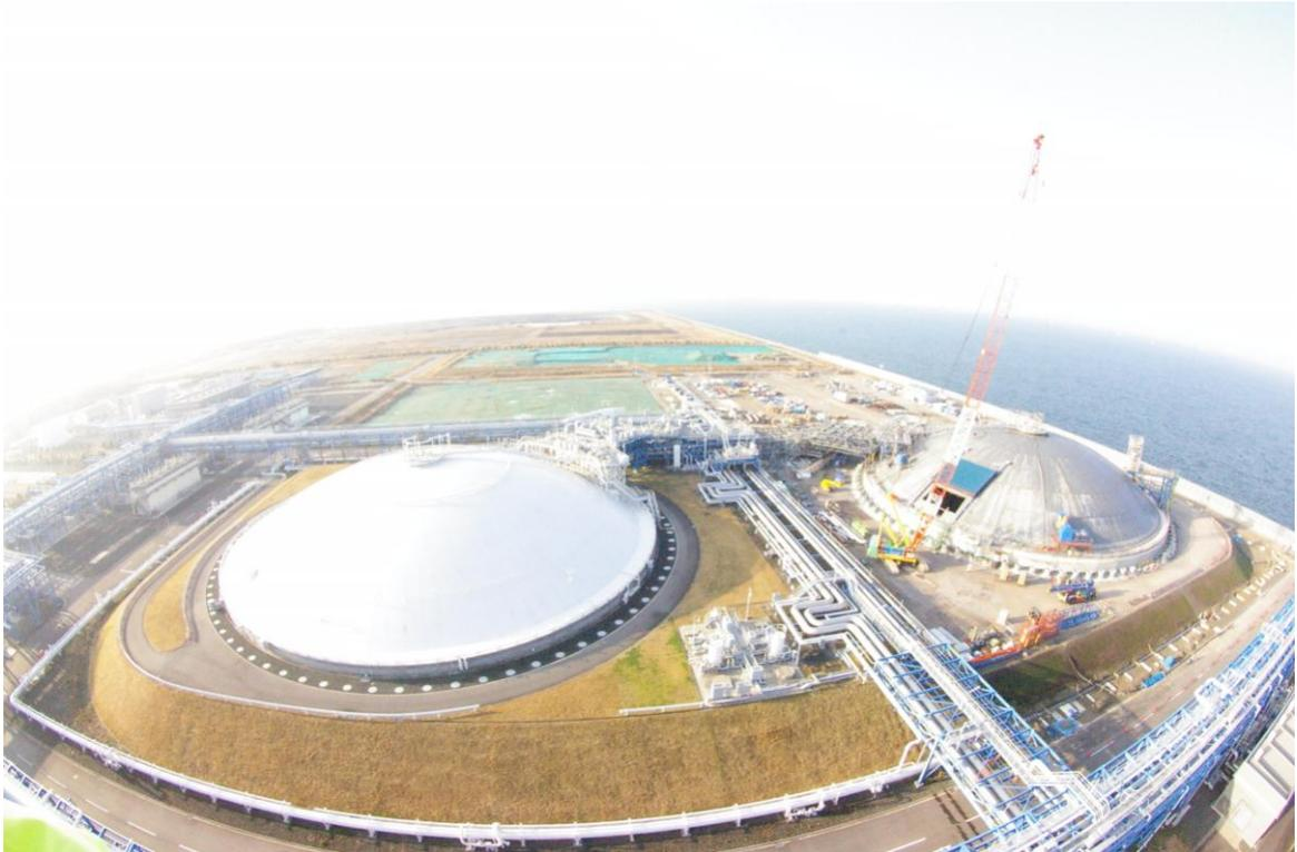
20万k l LNG地下式タンク（左稼働中，右建設中）（提供：東邦ガス）
