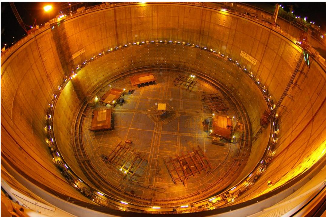
地下式LNGタンク建設状況（夜間）（提供：東邦ガス）
