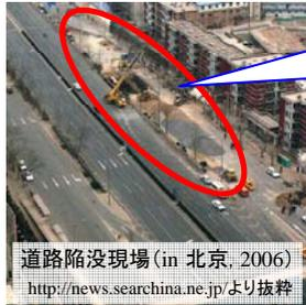
地下鉄工事の際に、上部の既設下水道管が破損し、陥没した。
